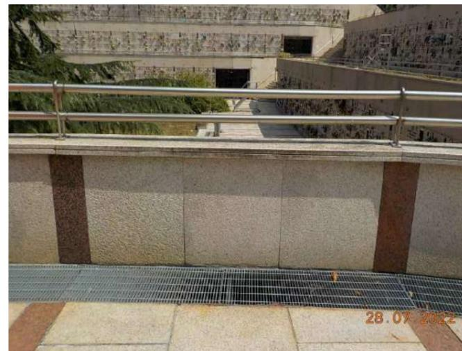
5 | dettaglio sostituzione fioriera con sistema scolo acque
